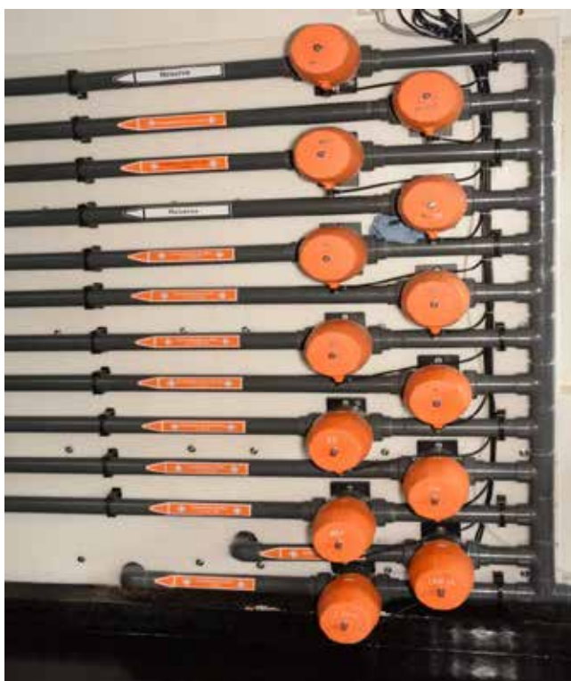
Abb. 2 Verteilung der fertigen Säuremischungen auf die entsprechenden Lagertanks
