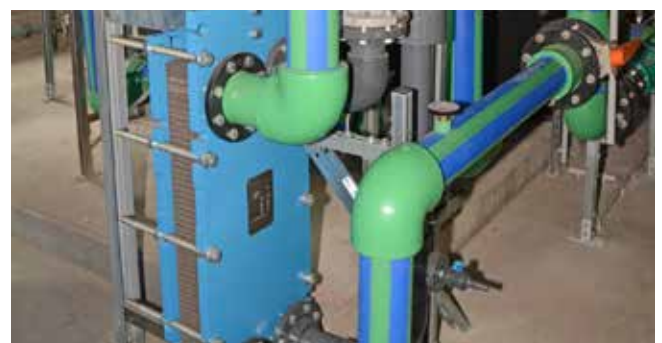
Abb. 7 NT- Pufferspeicher, mit Restwärmekühler
